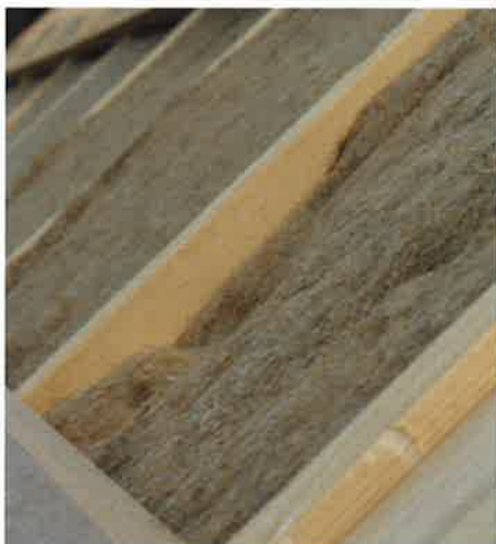
Toepassing van vezelhennep in het dakbeschoot Bron: Boeren voor Biobased Bouwen
