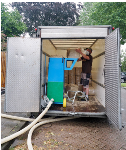
Inblaaswerkzaamheden in beeld
