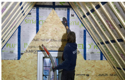
Opbouw voor inblaasisolatie
